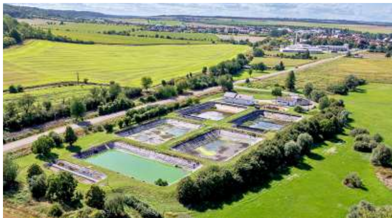
Ob die sechs Becken der Kläranlage Laucha zurückgebaut oder anderweitig genutzt werden, ist noch offen.
