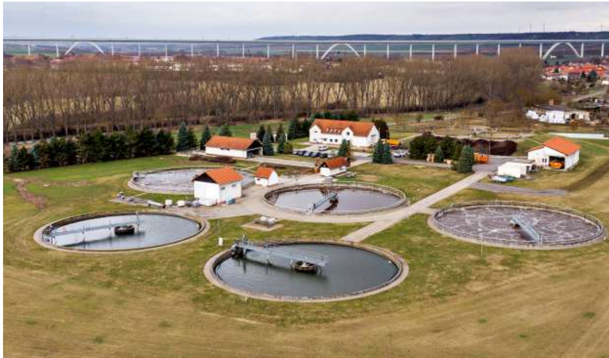
Die Kläranlage in Karsdorf soll für mehr Energieeffizienz umfangreich umgebaut werden.
